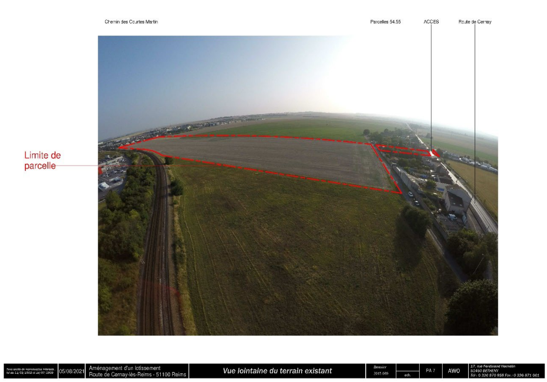
Figure 28 : Vue d'ensemble – Source AWO – Greem Immobilier
