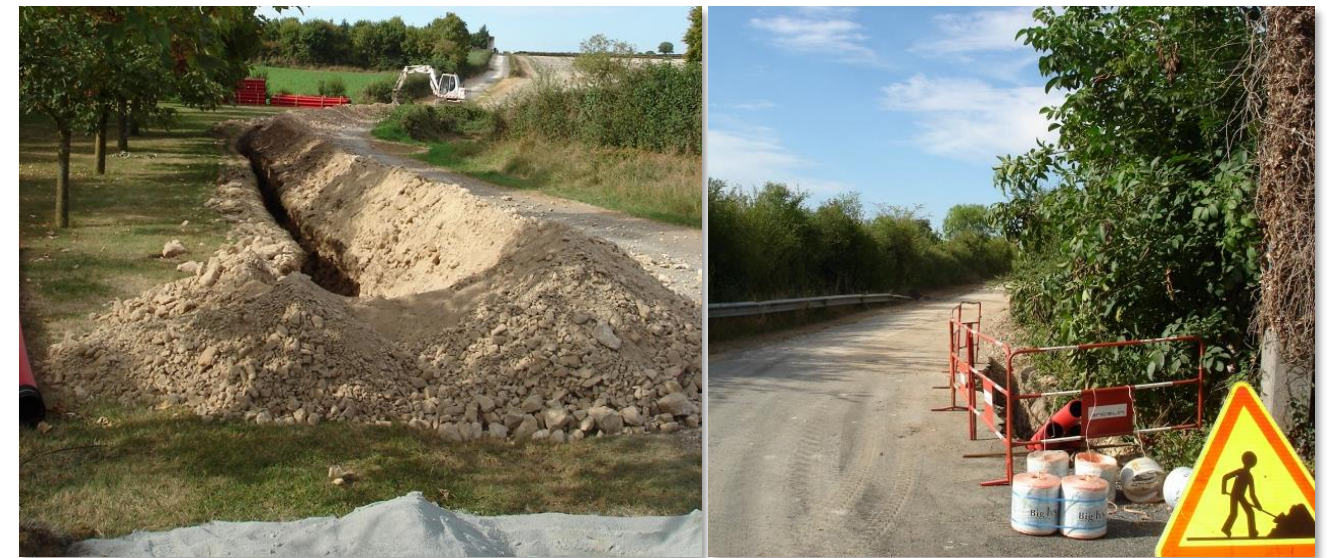
Figure 26 : Tranchée pour le raccordement au réseau local
