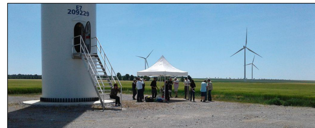
Figure 5 : journée portes ouvertes du parc éolien de Thibie (Source : VALOREM)
