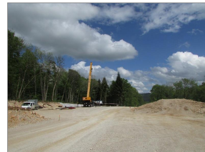
Figure 24 : illustration photographique d'une plateforme de grutage
