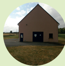
usine de SE de l'est Noyonnais (60), France 60 m 3 /h extensible à 120 m 3 /h
