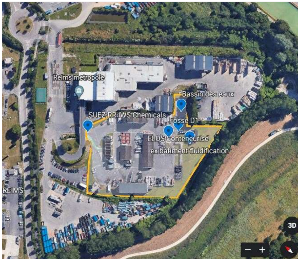
Figure 2. Vue aérienne des bâtiments du site
