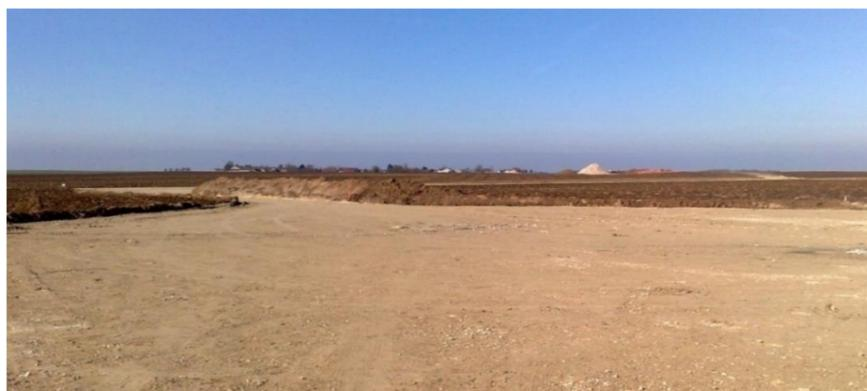
Figure 96 : Exemple d'aire de montage, grave compactée sur géotextile
