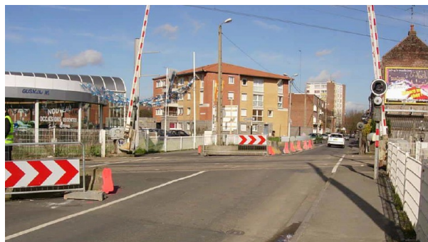
Figure 12: Chantier à proximité d'un PN
