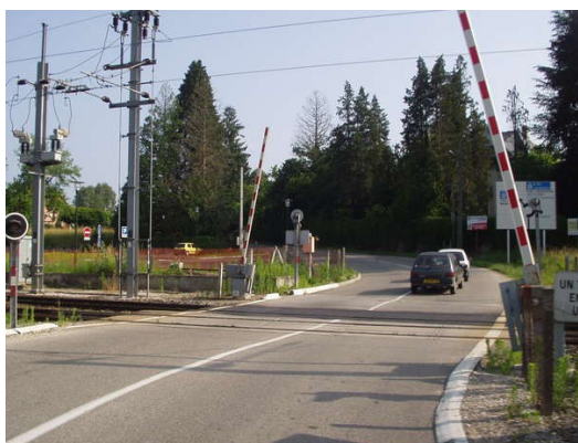
Figure 3 : PN muni d'une SAL avec barrières
